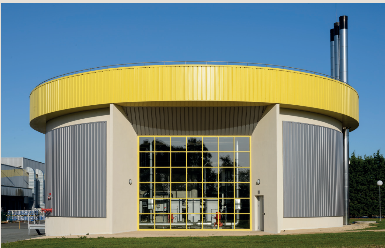
La chaufferie biomasse Celsius (Poujolat SA) - The biomass plant Celsius (Poujolat SA)
