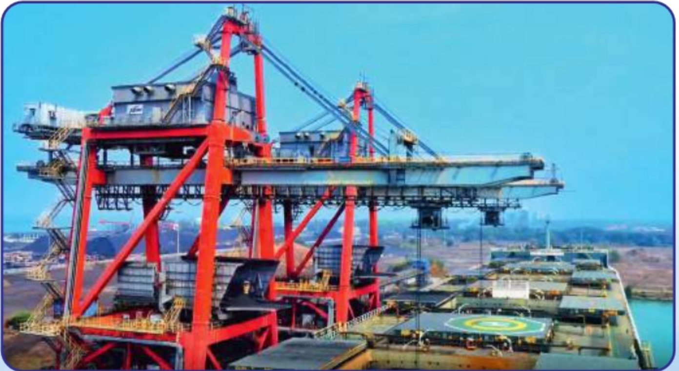
मशीनीकृत कोयला का संचालन Mechanized Coal handling
